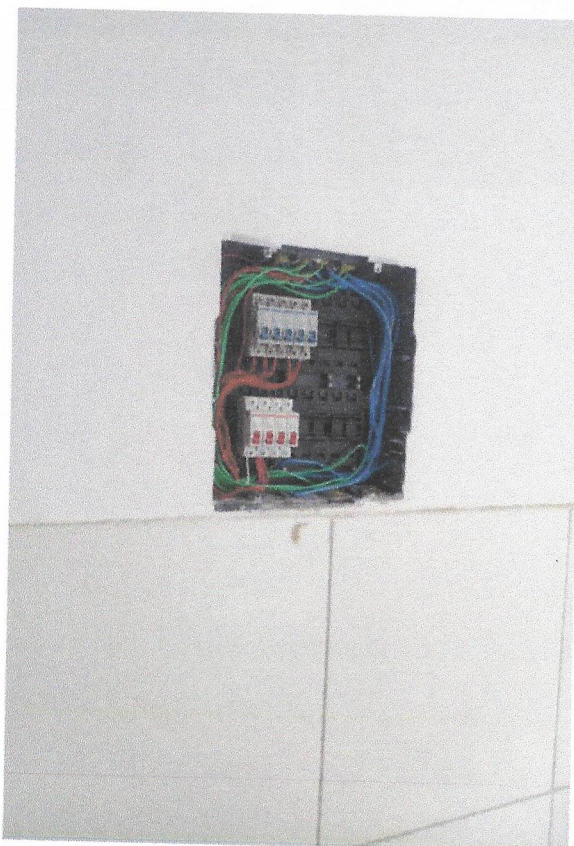
FOTO 08 - Quadro de distribuição de embutir para até 32 disjuntores padrão DIN, exclusive disjuntores
