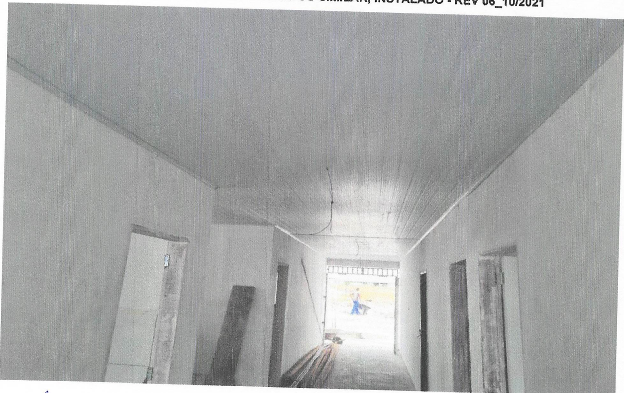
FOTO 04 - FORRO DE PVC, EM RÉGUAS DE 10 OU 20 CM, APLICADO, INCLUSIVE ESTRUTURA PARA FIXAÇÃO (PERFIS EM PVC) MARCA ARAFORROS OU SIMILAR, INSTALADO - REV 06_10/2021
