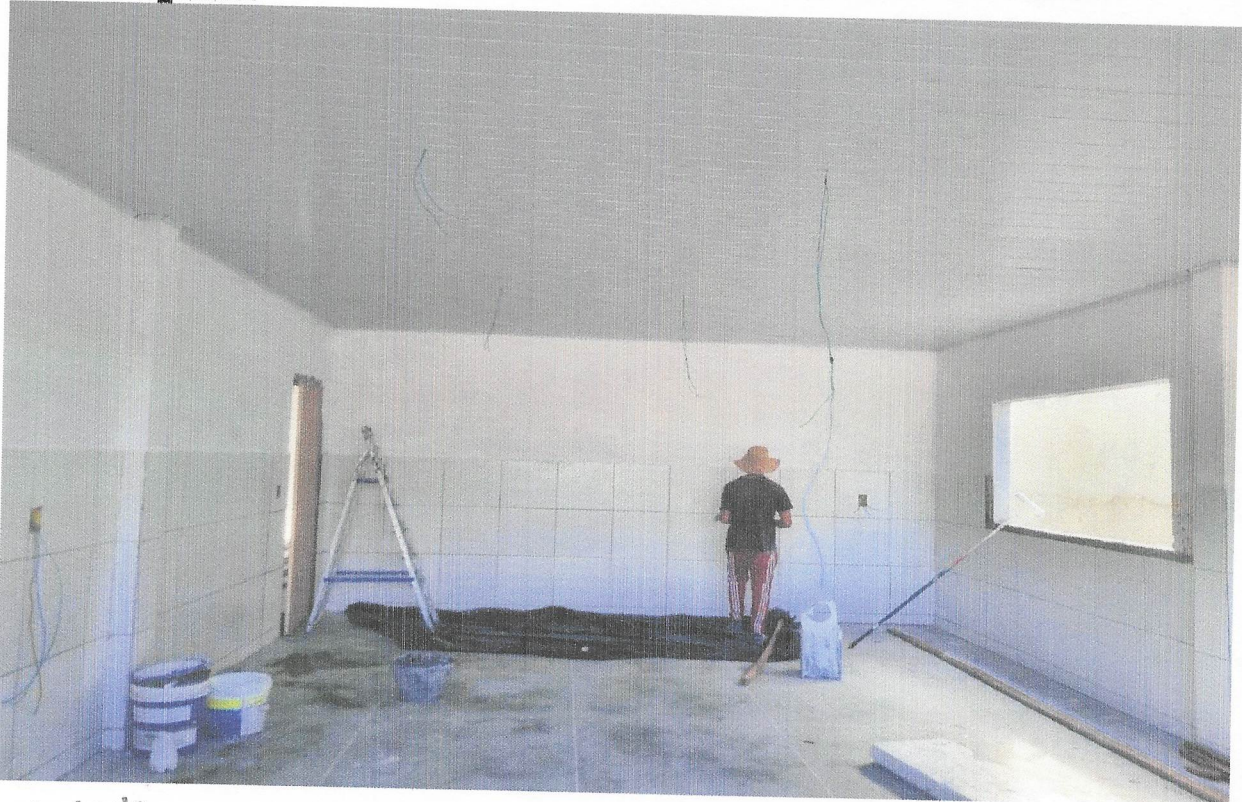
FOTO 16 - APLICAÇÃO MANUAL DE PINTURA COM TINTA LÁTEX ACRÍLICA EM PAREDES, DUAS DEMÃOS. AF_06/2014
