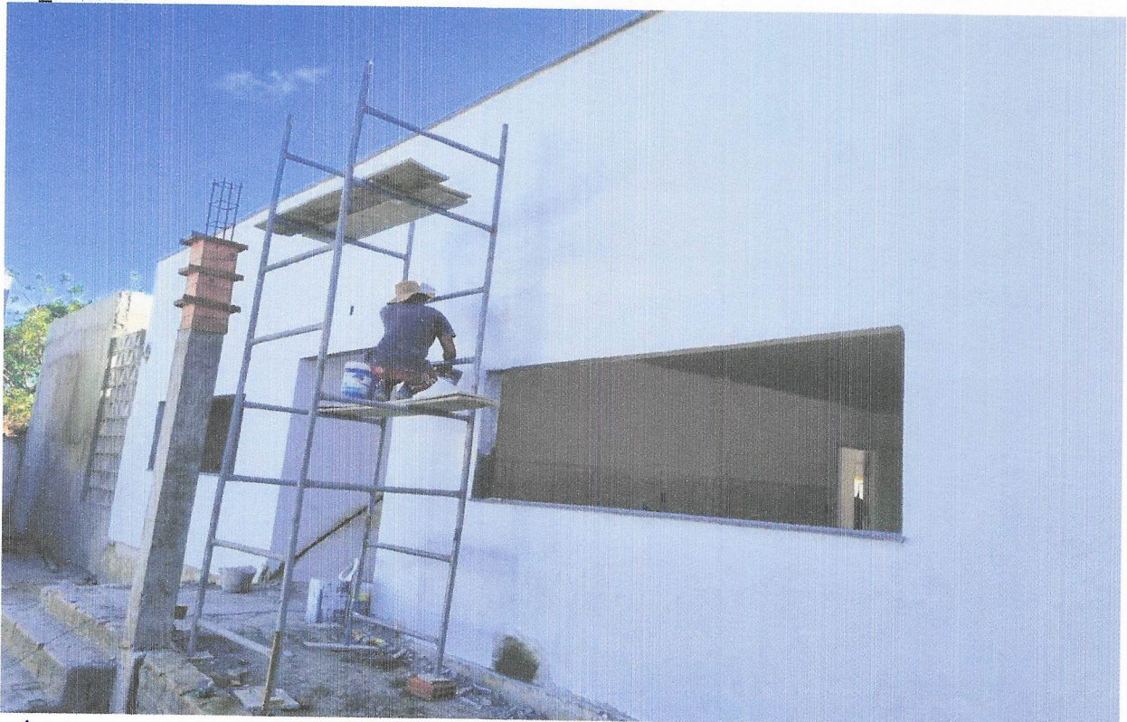
FOTO 14 - APLICAÇÃO MANUAL DE FUNDO SELADOR ACRÍLICO EM PAREDES EXTERNAS DE CASAS. AF_06/2014
