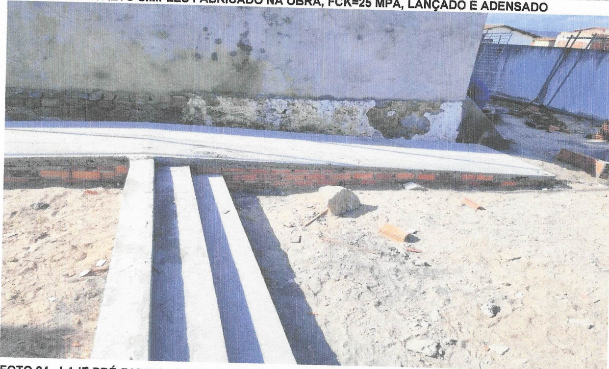
FOTO 24 - LAJE PRÉ-FABRICADA TRELIÇADA COM VIGOTA DUPLA PARA PISO, INTEREIXO 38CM, H=12CM, ENCHIMENTO EM BLOCO CERÂMICO H=8CM, INCLUSIVE ESCORAMENTO EM MADEIRA E CAPEAMENTO 4CM.
