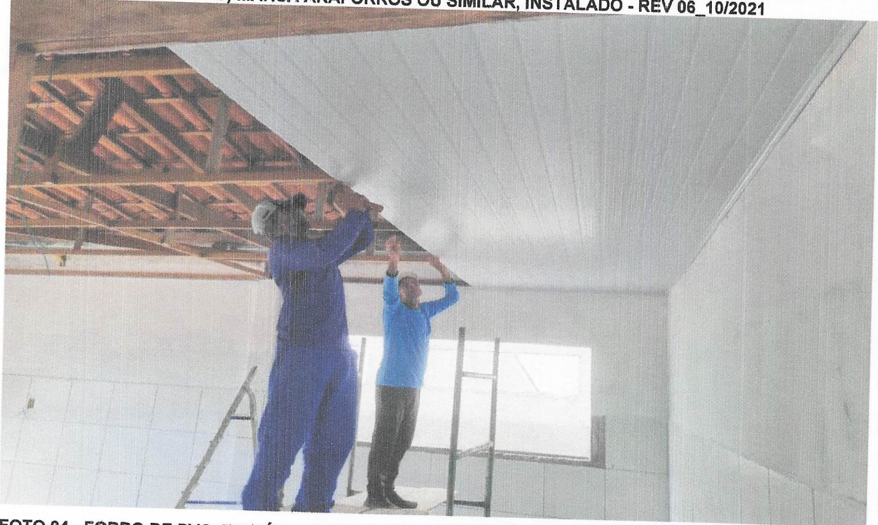
FOTO 04 - FORRO DE PVC, EM RÉGUAS DE 10 OU 20 CM, APLICADO, INCLUSIVE ESTRUTURA PARA FIXAÇÃO (PERFIS EM PVC) MARCA ARAFORROS OU SIMILAR, INSTALADO - REV 06_10/2021
