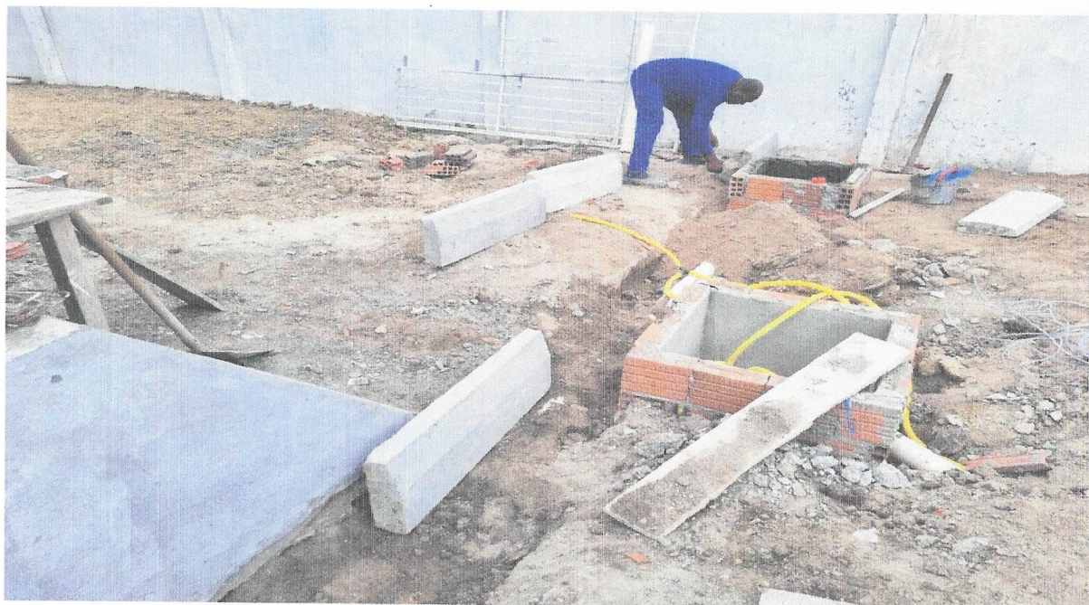
FOTO 30 - ASSENTAMENTO DE GUIA (MEIO-FIO) EM TRECHO CURVO, CONFECCIONADA EM CONCRETO PRÉ-FABRICADO, DIMENSÕES 80X08X08X25 CM (COMPRIMENTO X BASE INFERIOR X BASE SUPERIOR X ALTURA), PARA URBANIZAÇÃO INTERNA DE EMPREENDIMENTOS. AF_06/2016
