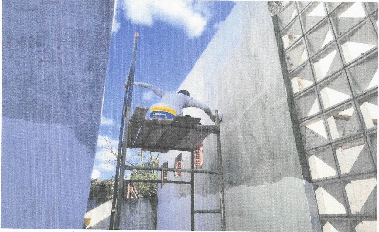
FOTO 14 - APLICAÇÃO MANUAL DE FUNDO SELADOR ACRÍLICO EM PAREDES EXTERNAS DE CASAS. AF_06/2014
