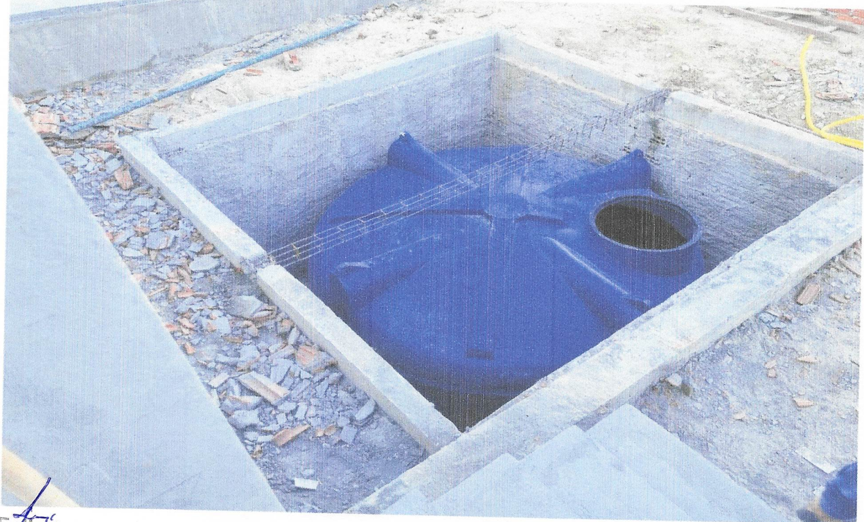
FOTO 22 - RESERVATÓRIO EM POLICARBONATO DE 15000 LITROS
