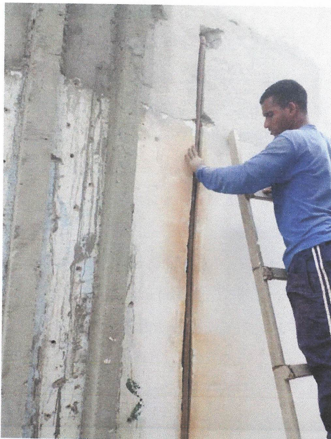
FOTO 28 - TUBO PVC SOLD. MARROM D= 20mm (1/2") PARA DRENO DO AR CONDICIONADO
