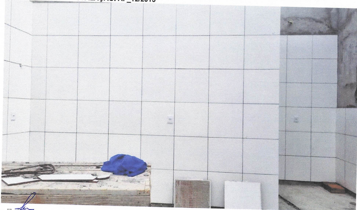
FOTO 20 - TOMADA BAIXA DE EMBUTIR (1 MÓDULO), 2P+T 10 A, INCLUINDO SUPORTE E PLACA - FORNECIMENTO E INSTALAÇÃO. AF_12/2015
