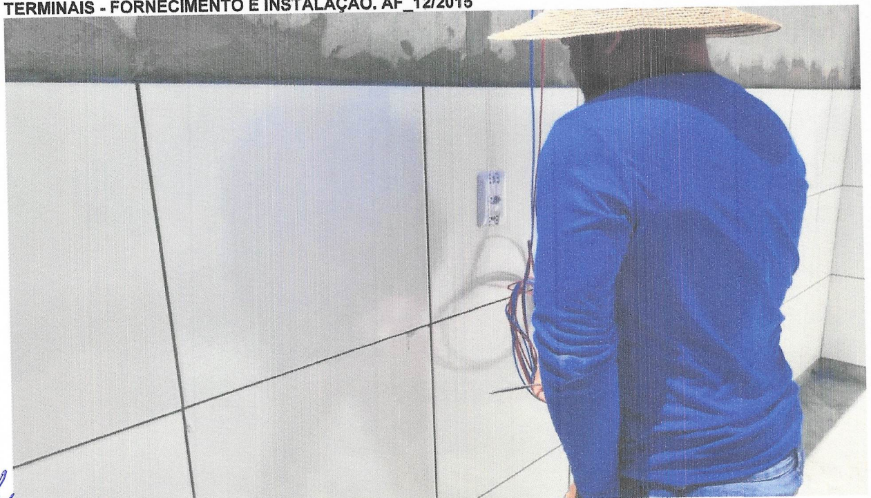
FOTO 18 - CABO DE COBRE FLEXÍVEL ISOLADO, 4 MM 2 , ANTI-CHAMA 450/750 V, PARA CIRCUITOS TERMINAIS - FORNECIMENTO E INSTALAÇÃO. AF_12/2015
